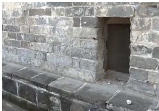
图 13 鄯阳大丰仓架空防潮通风孔
