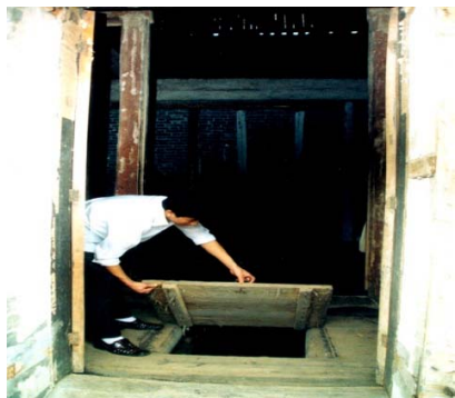
图 13 鄯阳大丰仓架空防潮通风孔
